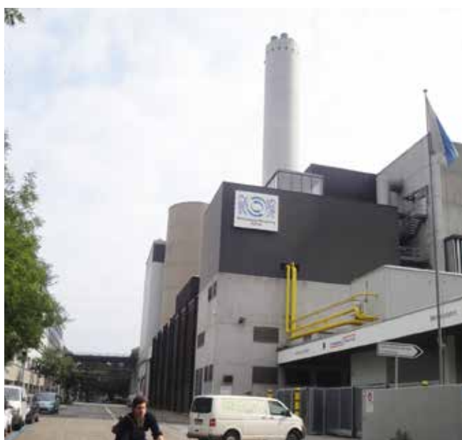
Kehrichtverbrennung Josefstrasse: Mit dem Wettbewerb für eine gewerbliche Umnutzung setzt der GVZ ein Zeichen.
